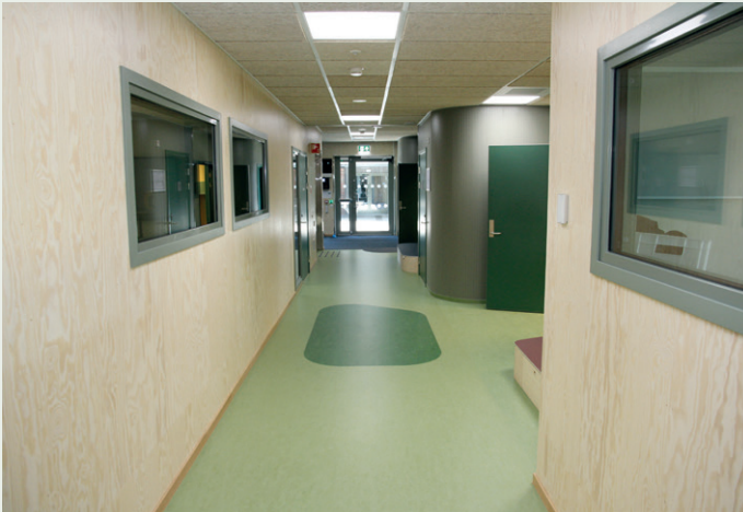
Korridorer med kryssfinér på veggene.
